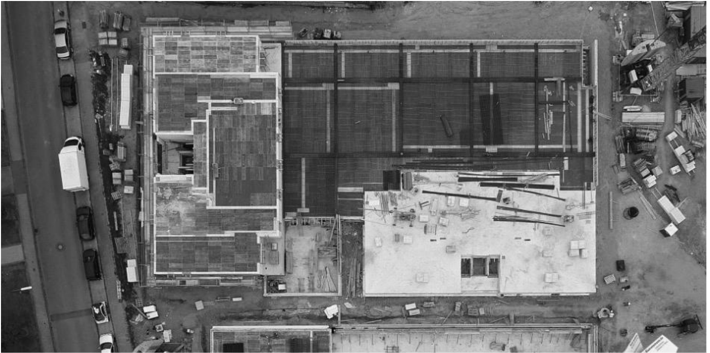
Abbildung 20: Baustellenaufnahme mit Drohne
